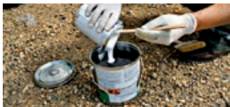
Het uithardingsmiddel in de basis gieten
