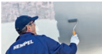
Underwater Primer opbrengen op geprepareerd oppervlak
