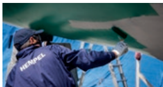
Antifouling opbrengen over primer of hechtverbeteraar
